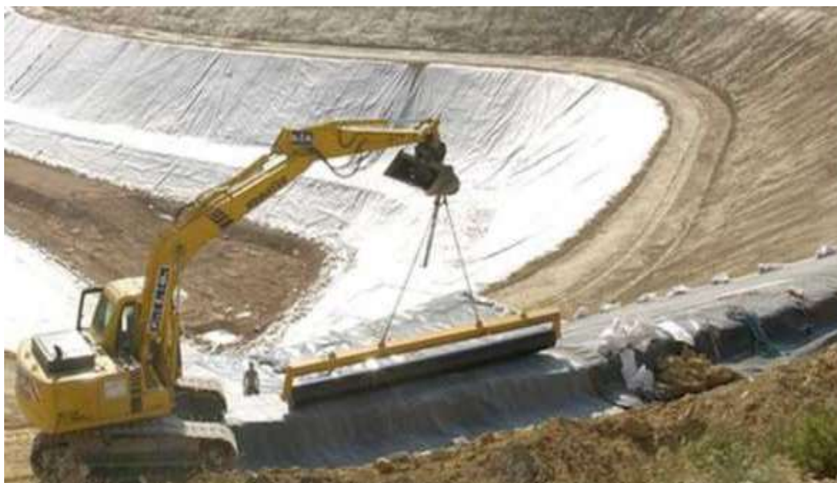
Расми 4.3.4. - Корҳои гидроизолатсионии зиддиполоишӣ дар иншооти гидротехникӣ бо усули геомембранаҳои тамғаи «Славрос»
