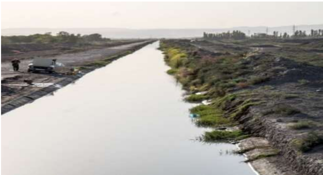
Расми 4.4.3. - Канали ирригатсионии Танобчй–Селбур
