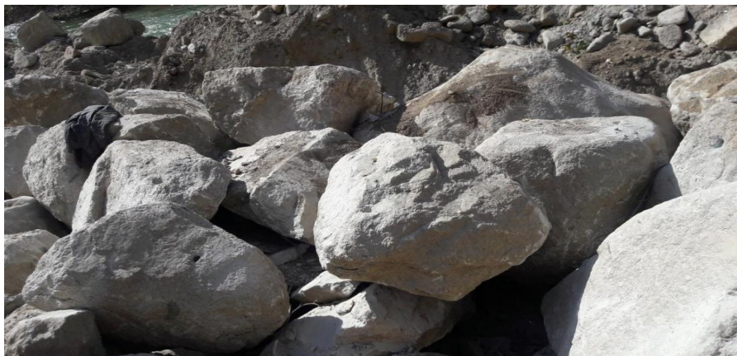
Расми 1.2.8. - Рафти корҳои соҳилмустаҳкамкунӣ бо усули сангҳои калонҳаҷм Акси навбатӣ нишон медиҳад, ки корҳои соҳилмустаҳкамкунӣ дар иншооти мазкур ба итмом расонида шудааст.
