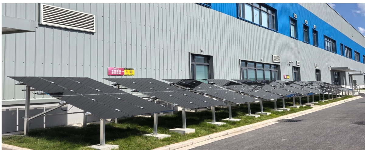
Рис. 1.3. Масштабируемая конструкция на базе перовскитных СЭ, разработанная и реализованная в Нанкинском университете (КНР)
