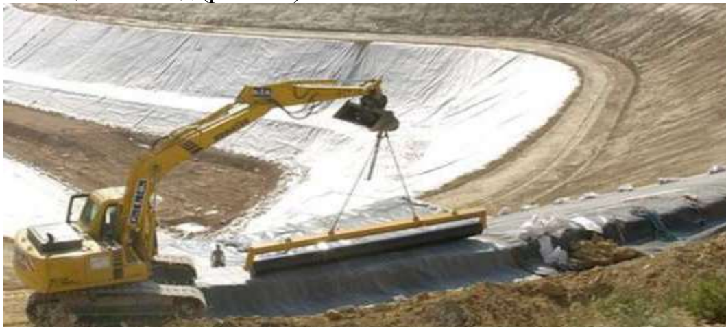
Расми 8. - Корҳои гидроизоляцияи зиддиполоиш дар иншооти гидротехникӣ бо усули геомембранаҳои тамғаи «Славрос»
