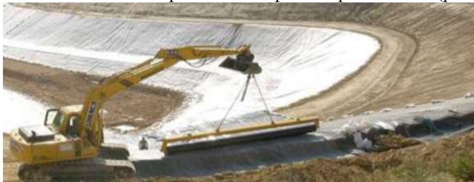
Рисунок 8. - Работы по противозагрязнительной гидроизоляции гидротехнических сооружений методом геомембран марки «Славрос»
