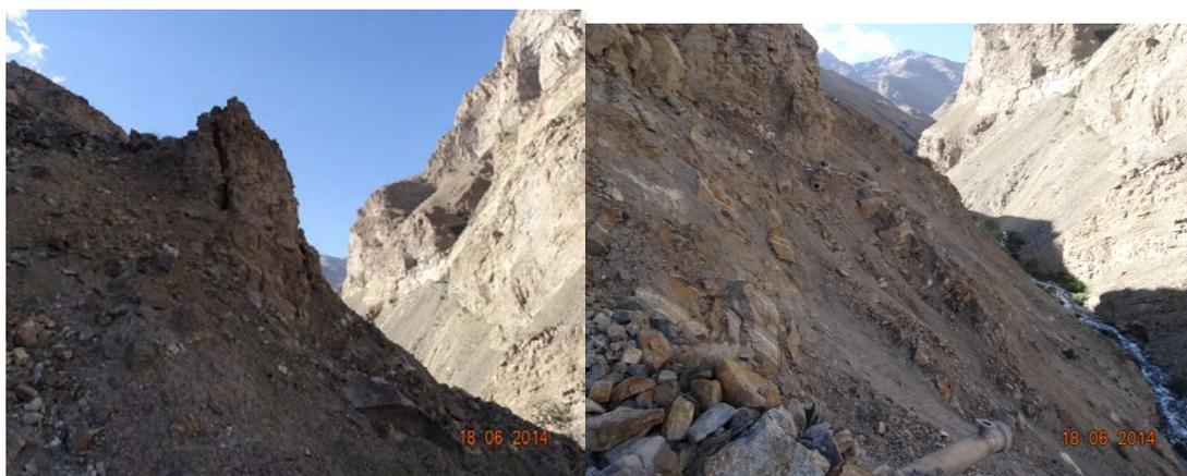
Рис. 10. Оползнеопасный склон Занудж. Разрушенная часть канала в результате активизации оползня
