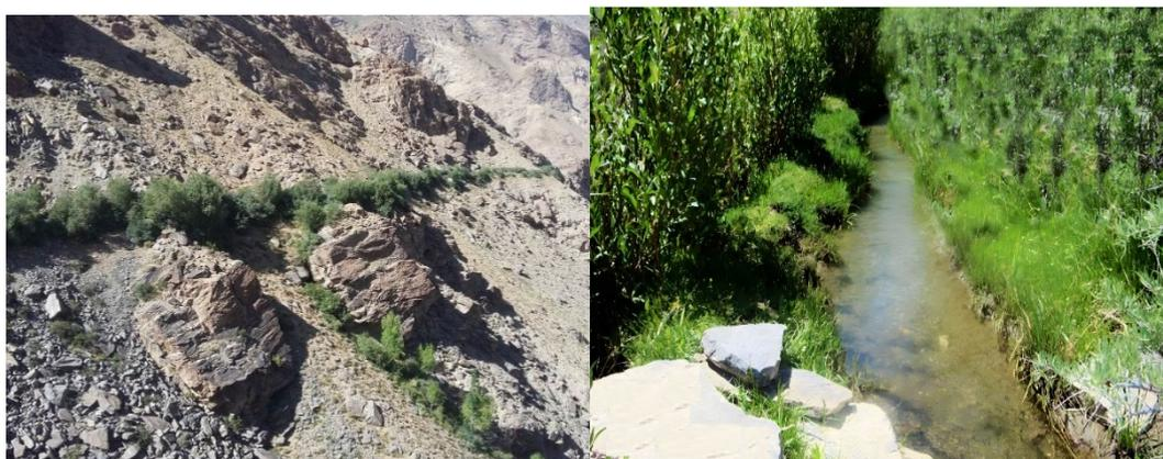
Рис. 3. Проложенный без гидроизоляции земляной канал Вездара-Миденвед, который является главным фактором образования техногенного оползня
