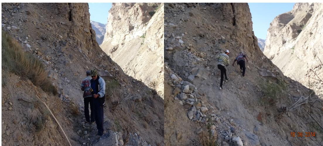
Рис.11. Разрушенная часть канала по саю Оджатга в результате оползневых явлений
