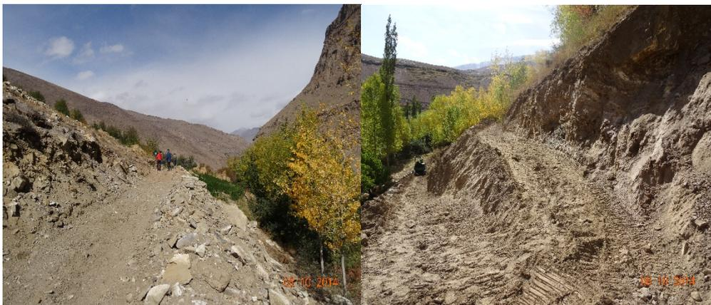
Рис. 6. Разгрузка оползневой склона методом террасирование
